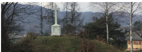
Obr. č. 5: Pohľad na Stross od cintorína a Altánok na „Strosse“
